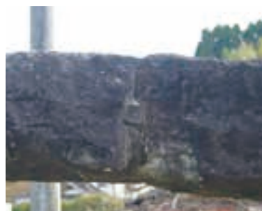
洞口橋に見られる楔石の跡
